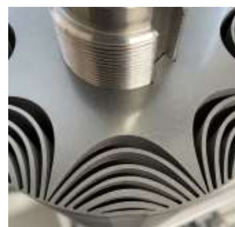
図2 発電機の回転子 (5号機)
