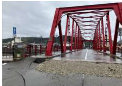
道路陥没の応急復旧状況
